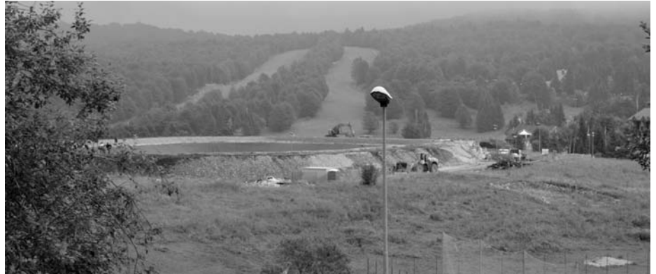
Piancavallo Il nuovo bacino conterrà l'acqua per la neve artificiale
