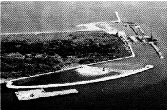
Bocca di Chioggia: Il porto rifugio e le piattaforme in cemento a ridosso di Ca' Roman
