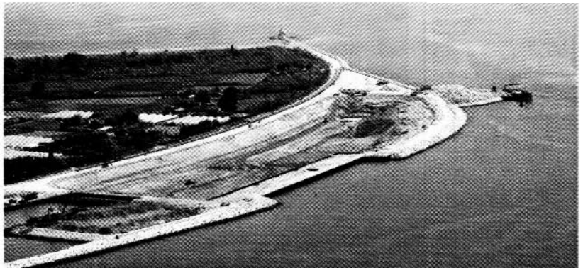
La nuova massicciata e il cemento per il porto-rifugio a Punta Sabbioni
